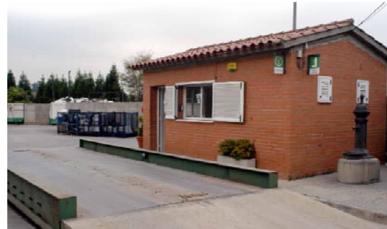
Punt de partida per a la bona gestió de la instal·lació
