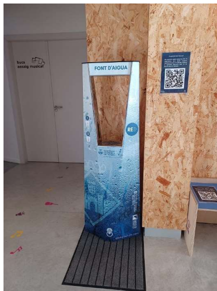
Figura 4. Punt d'aigua instal·lat en edificis municipals. Font: Ajuntament de Vilafranca, 2023.
